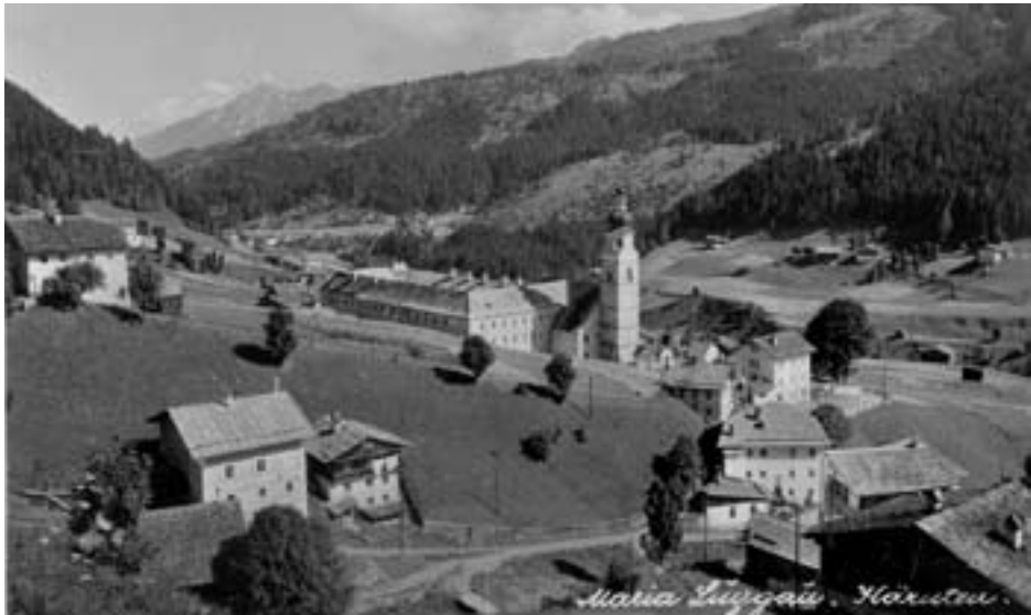
Postkarte Maria Luggau – mit unserem Haus inkl. intakter Werkstätte im Vordergrund. Steiler und breiter Weg sind gut zu erkennen ebenso der Bäckwirtstadel. Das Hansela-Stammhaus noch weitgehend im Originalzustand vor der Renovierung.
