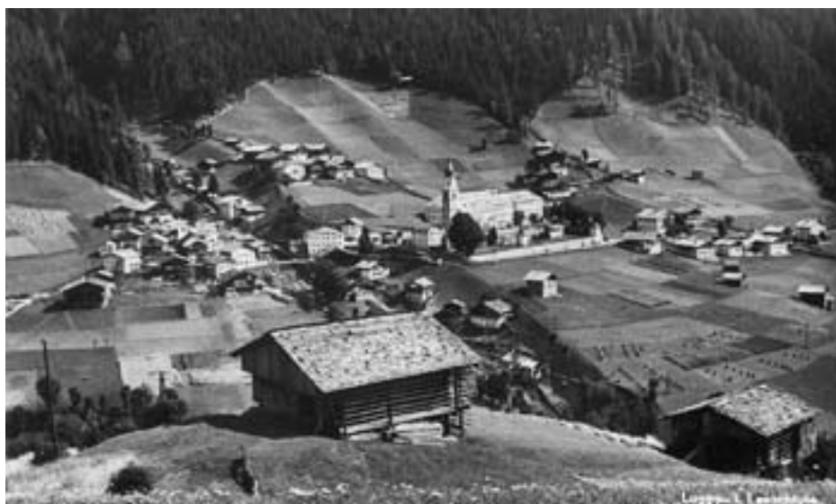
Luggau um 1960. Bei uns steht noch die Werkstätte, das Haus hat ein neues Blechdach, wie andere auch. Neu im Bild die Zollhäuser unterm Paternwirt und Vorbeter Polds Haus unterhalb der Klostermauer, Maurer Tischlerwerkstatt ist erweitert.
